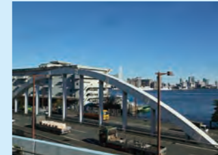
アーチが美しい新日の出橋。臨港道路により芝浦ふ頭と日の出埠頭が繋がっています
